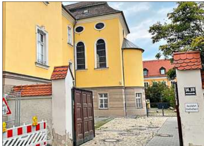
Das Einfahrtstor zum Eingang in die Stiftskapelle in der Weitoldstraße 16 in der Altstadt Foto: Landsmann
