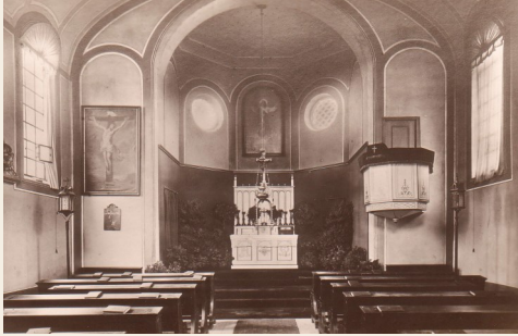
Die Auferstehungskirche im Wandel der Zeit: ca. 1931 und 1946
