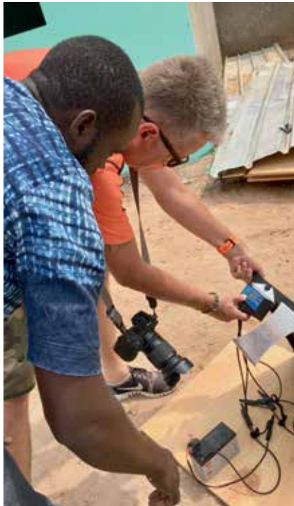
Stefan Kölbl installiert eine PV-Anlage mit Lehrer Yaya Badji.
