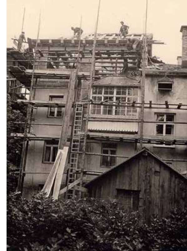
Umbau Gemeindehaus (Foto Archiv)
