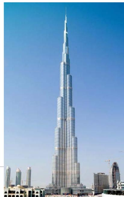
*Foto: Das derzeit höchste Hochhaus der Welt, der Burj Khalifa in Dubai, mit 828 m Höhe und 163 allgemein nutzbaren Etagen, gebaut aus Stahlbeton und Stahl.*
