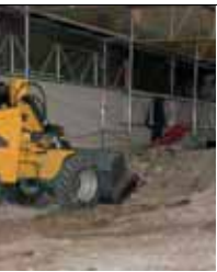
Kirchenraum während der Bodensanierung
