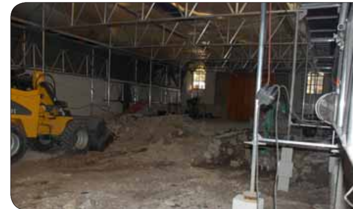
Grabungsarbeiten in der Kirche
