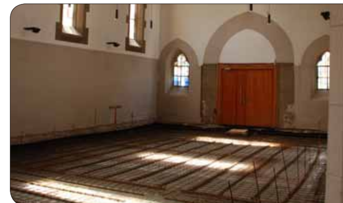
Stahlarmierung für die neue Bodenplatte
