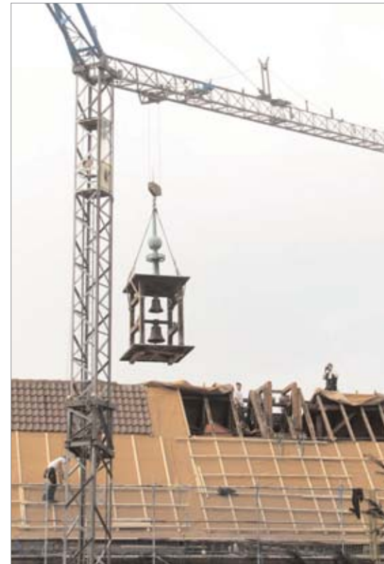
...und mit dem Kran vom Dach gehoben werden.
