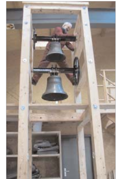
Inzwischen ist der Glockenturm in der Zimmerei neu konstruiert und die Glocken bereits wieder eingebaut. Wir hoffen, dass der Turm bald wieder auf das Dach montiert werden kann.
