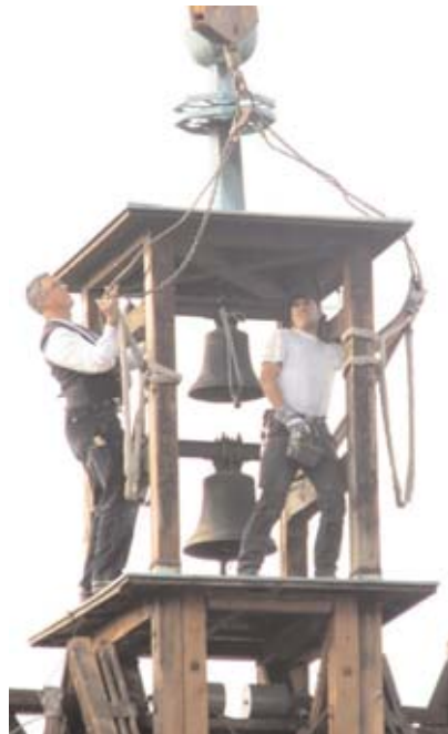
Danach musste der Glockenturm abgebaut...
