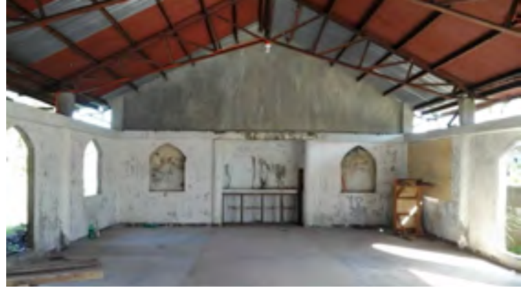
Die teilweise wieder aufgebaute Kirche des Missionszentrums mit dem wiederhergestellten Kirchendach
