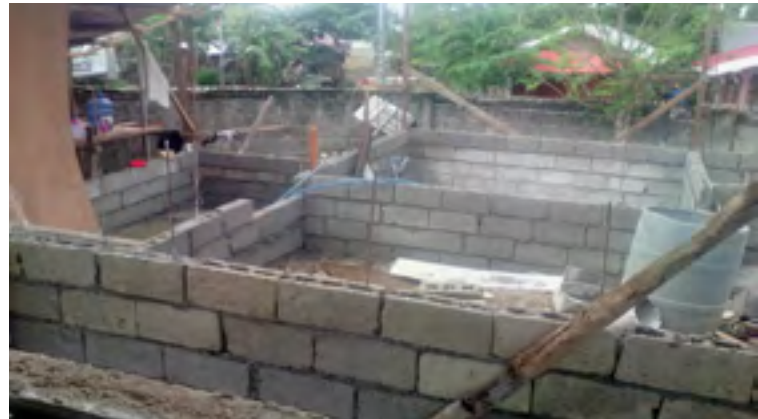
Bauarbeiten, die derzeit am Pfarrhaus in Buenavista durchgeführt werden
